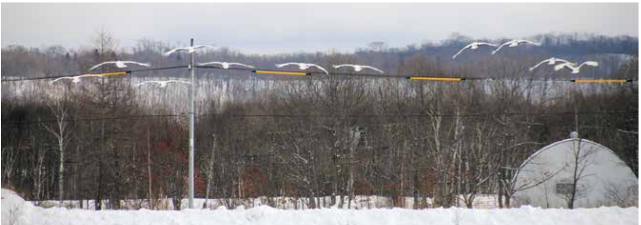
Powerline markers to prevent collisions 防止碰撞的电力线标记 衝突防止のための電線標識 충돌 방지를 위해 전선에 유색 마커 부착 Желтые маркеры линий электропередачи для предотвращения столкновений
